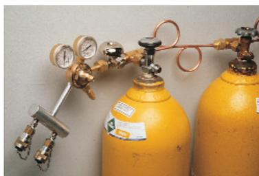
Bouteilles à air pressurisé reliées entre elles par l'ajout de tés (raccords en "T") et de tuyaux en "tire-bouchon", munies de l'avertisseur sonore Audi-Larm et du régulateur de la pressurisation bouteille.
